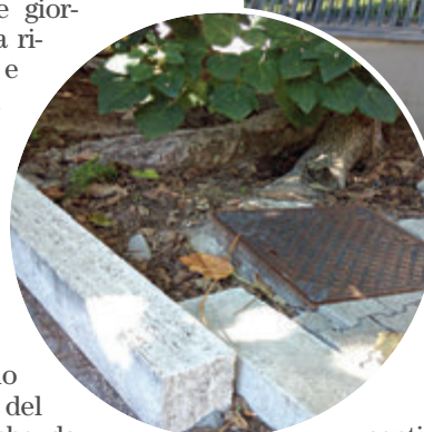
PIAZZA THOVEZ Radici di albero ad alto fusto danneggiano il marciapiedi ed il manto stradale.
